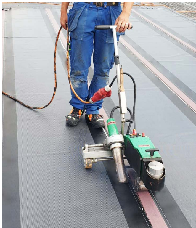
Fig. 4 : Soudage à l'air chaud tel que le soudage du recouvrement bitumineux à une couche.
