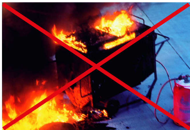
Fig. 22 : Exemple négatif d'un fondoir à bitume qui a pris feu, sans bac de débordement et sans distance de sécurité par rapport à la bouteille de gaz.
